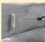
プライマー塗布
