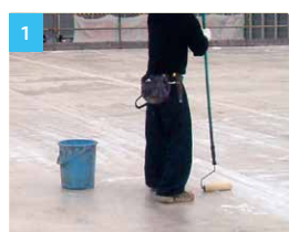
プライマー塗布
