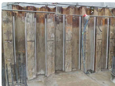
シートパイル
